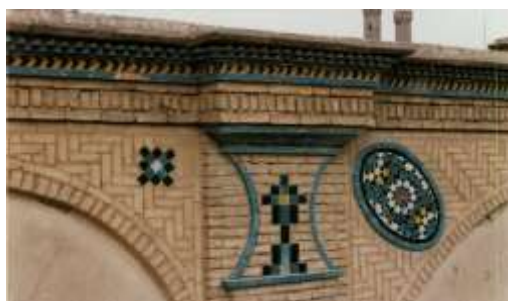
شکل(۵) کاشی پیش بر در دیوارهای حیاط خانه شاکری
