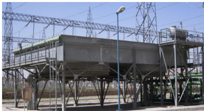
شکل ۱: نمایی از مبدل حرارتی هوا-آب.
