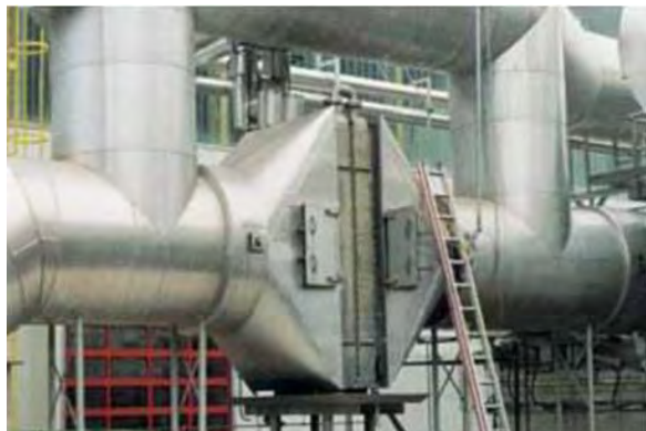
شکل ۱: مبدل حرارتی لوله ای پره دار
