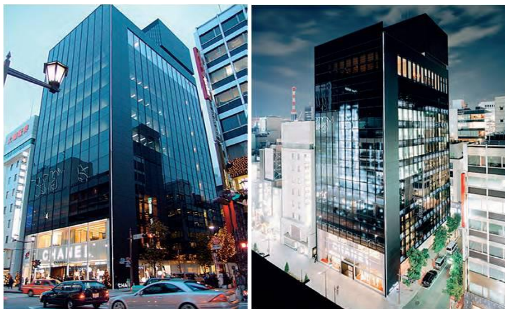
شکل شماره ۵: نمای ساختمان شب و روز اداره مرکزی کمپانی شانل توکیو
