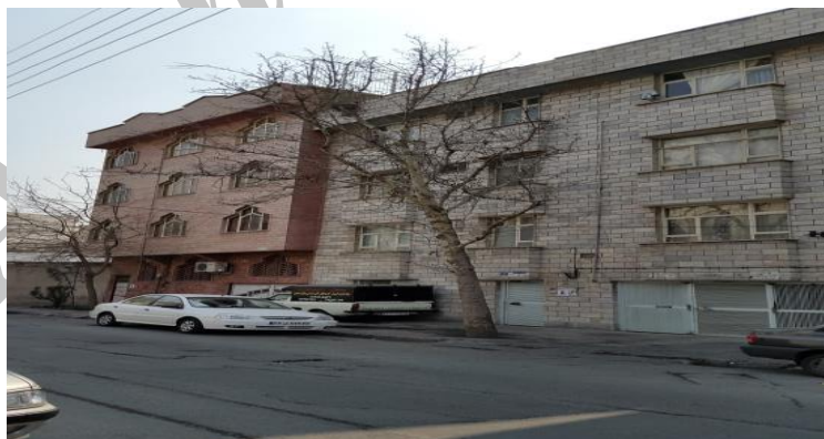
تصویر شماره 3- ساختمان های 4 طبقه با طرح پنجره های نا همگون
