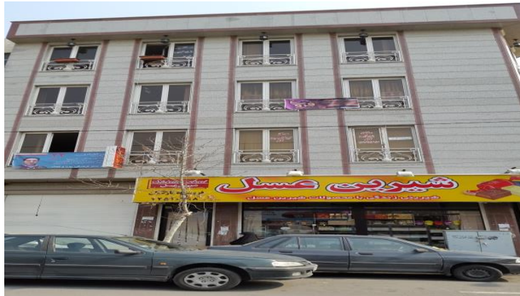
تصویر شماره 4- ساختمان مستقل از نمای همسایگی
