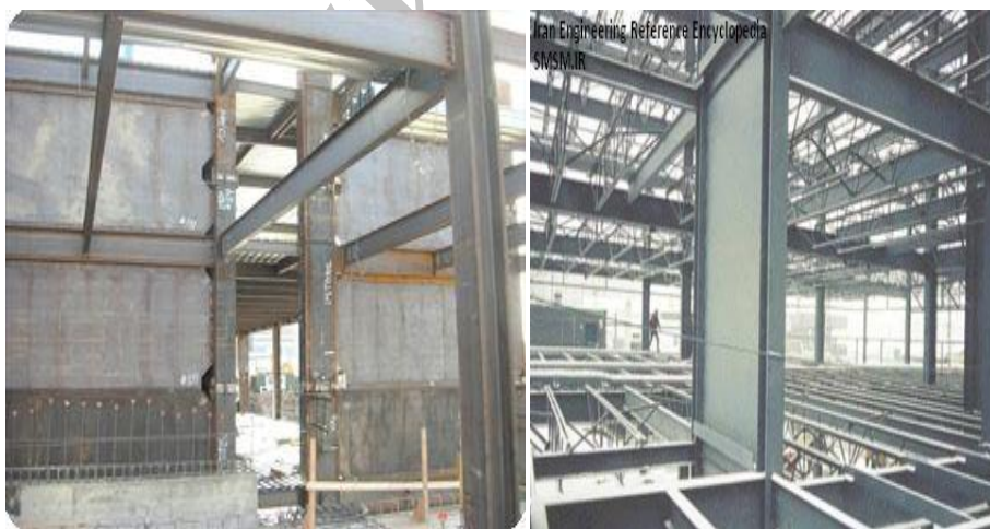
شکل 1: نمونه ای از دیوارهای برشی فولادی
