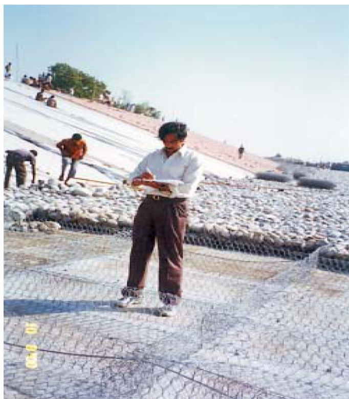
عکس(3): نمونه ای از انجام عملیات اجرای گابیون در ساحل رودخانه در کشور بنگلادش
