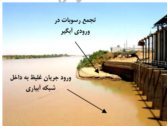
شکل (۲) گسیختگی صفحه‌ای ساحل رودخانه و ورود رسوبات به داخل جریان آب در رودخانه کارون (تصویر راست)، تجمع رسوبات در محل دهانه آبیگر شبکه آبیاری ویس و ورود جریان غلیظ به داخل شبکه آبیاری (تصویر چپ)
