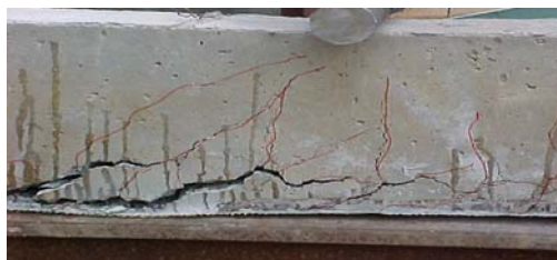
شکل ۸- جداسدگی بتن از آرماتورهای طولی
