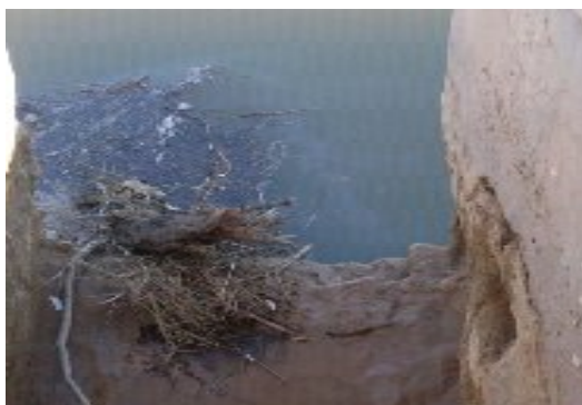
شکل (۴) تنه درختان و زباله در ورودی دریچه
