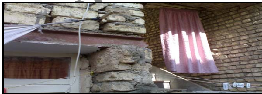
شکل ۶ قرارگیری تیرهای سقف مستقیماً بر روی دیوار
