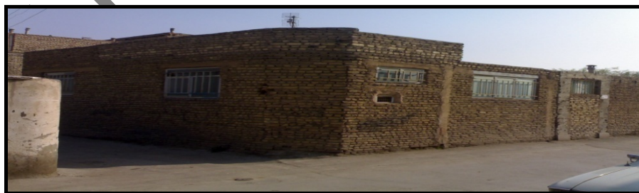
شکل ۷ حذف اعضای سازه‌ای در ساختمان مسکونی
