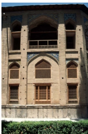
شکل ۳. نمای آجری بنا
